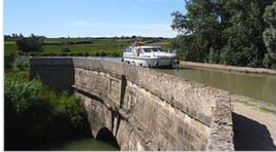
Kanalbrücke über den Fluss Répudre (Pont de Répudre)
